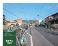
車道の切り直し状況
