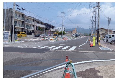
対象工事【街路改良工事】
