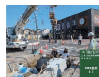
横断函渠の施工状況
