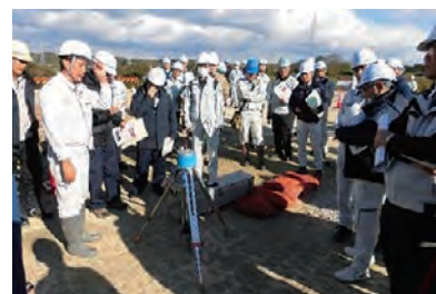
現地研修【バイパス道路改良工事】
