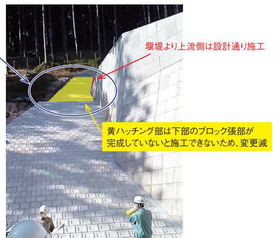
右岸下流側施工済写真 (発注時は下部のブロック張部は埋戻しされていなかった)
