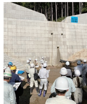
現地研修【東林沢砂防工事】
