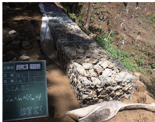
ふとん簀設置完了
