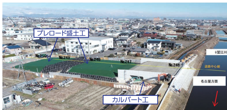
名古屋津島線バイパス(七宝工区)右岸工事
