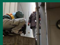
建物奥での境界設置作業（ブロック標上の作業）
