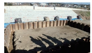
橋脚部仮設土留工
