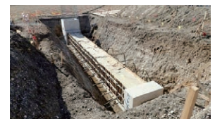
伏越し工 場所打ち函渠工
