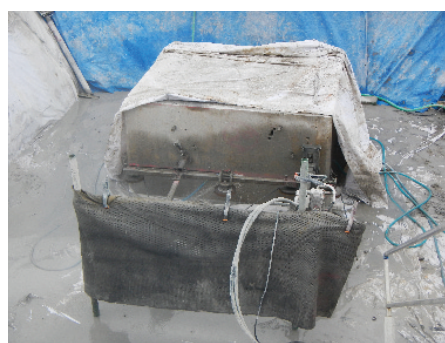
ワイヤソー工法による躯体切断
