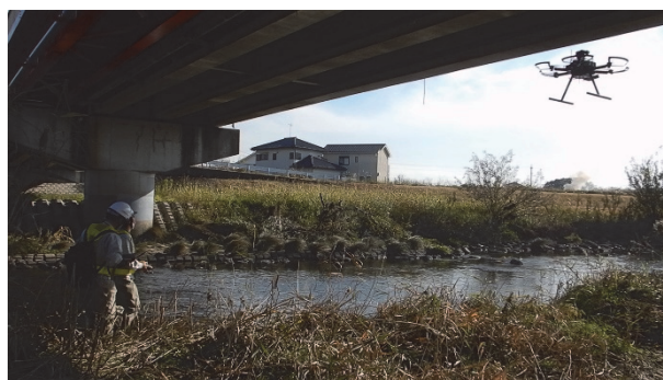
ドローンによる橋梁点検
