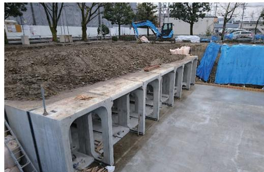
図3 都市型水害を軽減する雨水貯留施設
