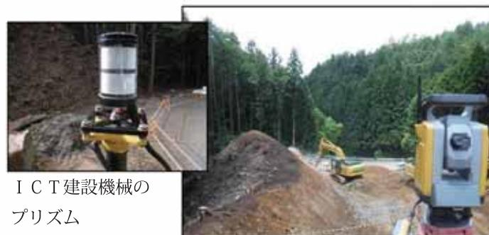
I C T建設機械のプリズムを追尾するT S測定器
