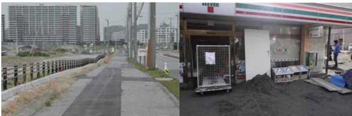
図-9 浦安の液状化被害：東日本大震災：(左上) 波打つ道路、激しい液状化に加えて、液状化してやわらかくなった地盤を長くゆさぶられているためと考えられている；(左下) 隆起する歩道（下水管が埋設されている、傾く交通構造物）；(右上) 大量の噴砂
