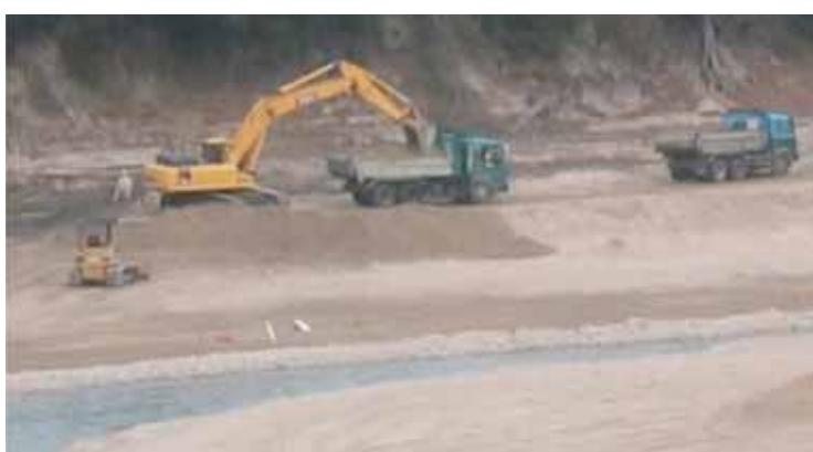
ダム湖に堆積した土砂の掘削工事
