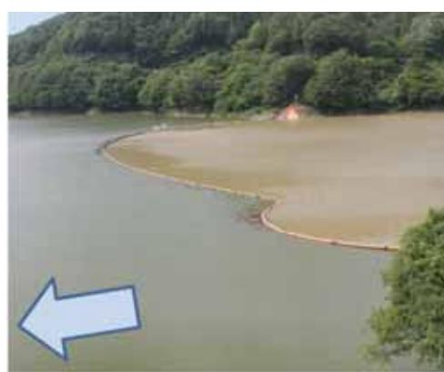
ダム湖設置した濁水対策フェンスによる効果
