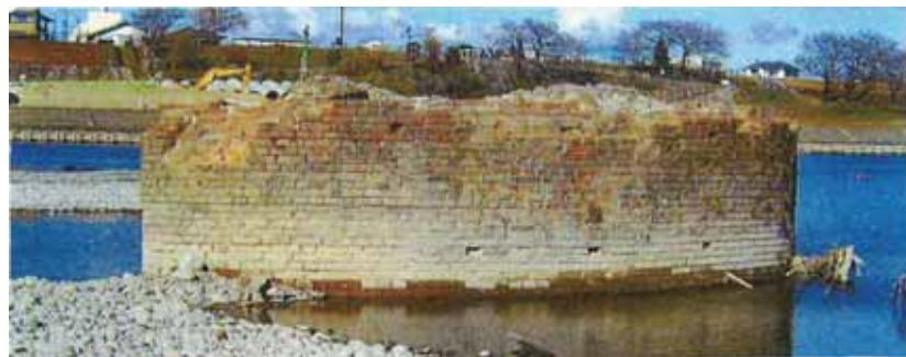
図一11 残存レンガ巻き建て補強工の側面写真（P 3）
