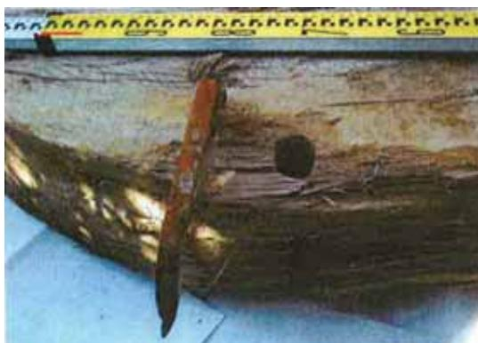
図-26 盤木と補強リング連結ボルト設置穴、鎌（カスガイ）
