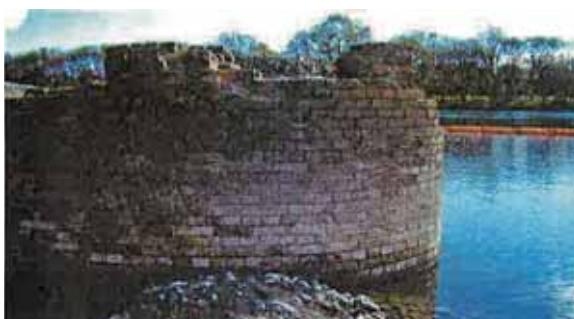
図-18 補強レンガ巻き建て躯体外観
