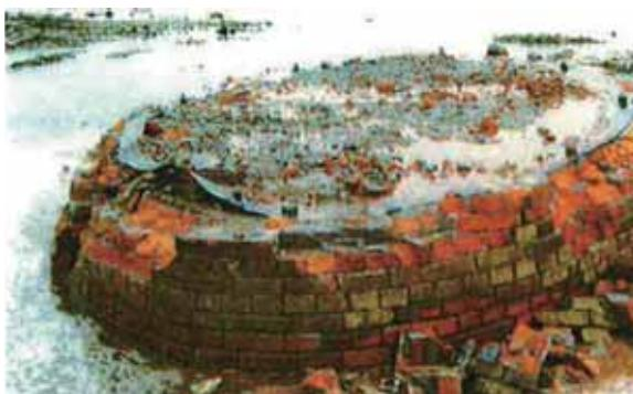
図-22 補強鋼板リングの設置状況
