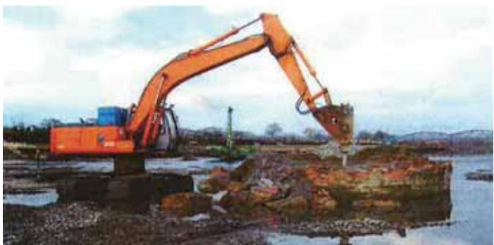
図-27 取り壊し機械＝大型ブレーカー
