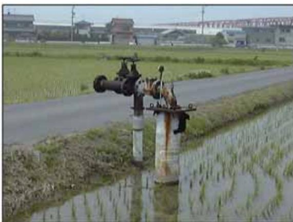
写真-2 濃尾平野の地盤沈下 井戸抜け上がり
