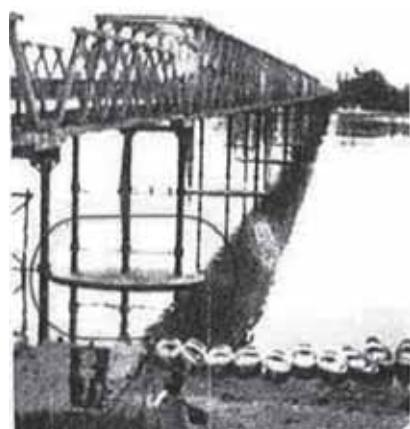
図一5 大正時代に鋼管井筒基礎が「レンガ巻き建て」で補強された旧木曽川橋<sup>(8)</sup>
