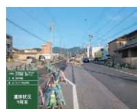
車道の切り直し状況
