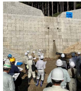
現地研修【東林沢砂防工事】
