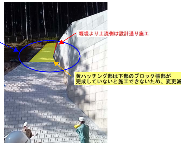
右岸下流側施工済写真
