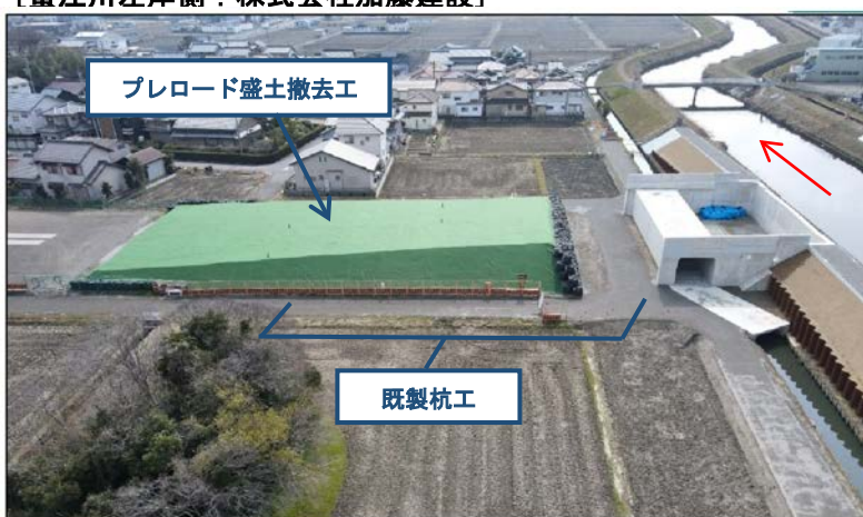
名古屋津島線バイパス（七宝工区）左岸工事
