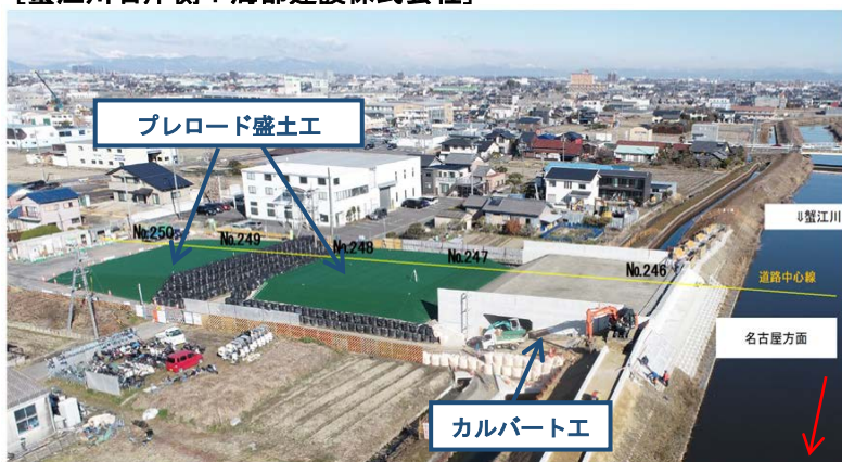
名古屋津島線バイパス（七宝工区）右岸工事
